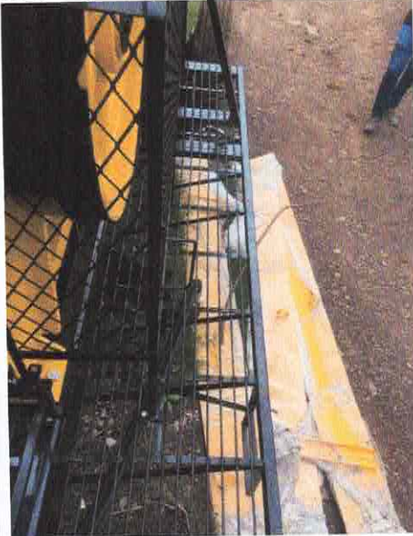
(Risco de queda e acesso sem restrição e puxador aux. de subida feito com ferro de constr. civil)
